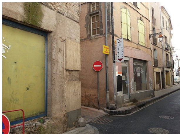
Rue Chassefière, commerces et immeubles désertés
